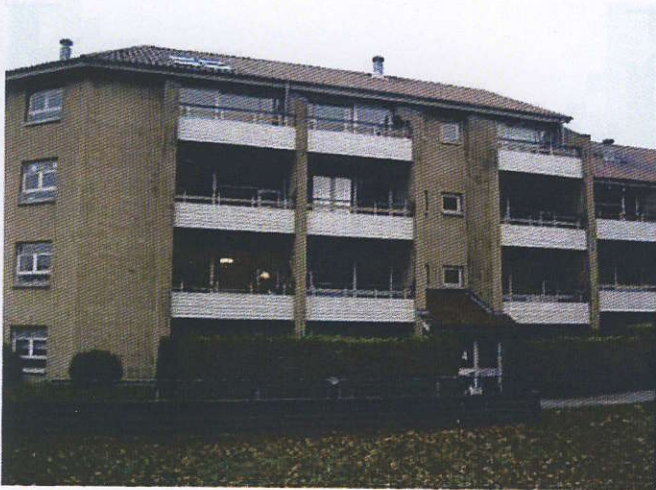
Altanrækværker ifm. lejligheder i opgang 1-16 er udskiftet til aluminium.
