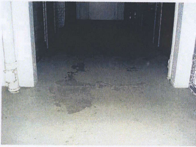
Malet betongulv i gangarealer i kælder fremstrå med afskallet maling mange steder
