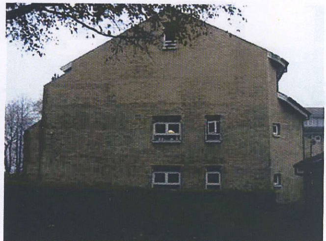
Gavl v. opgang 16
