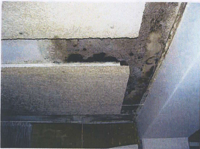
Skimmelsvampeangreb på loft i fællesrum i kælder
