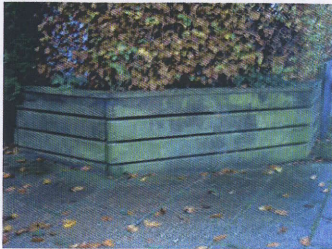
Træværk omkring blomsterbede trænger til afrensning og træbeskyttelse mange steder
