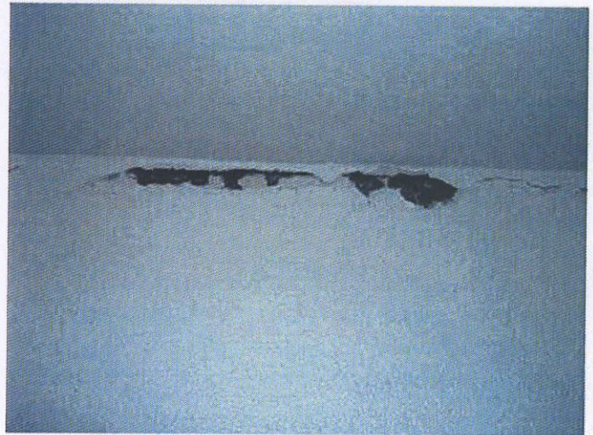
Sætningsrevne i trapperum
