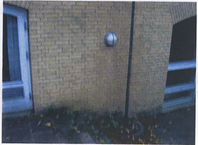
Murværk ved fælleslokaler er et enkelt sted behandlet med et algebekæmpende middel
