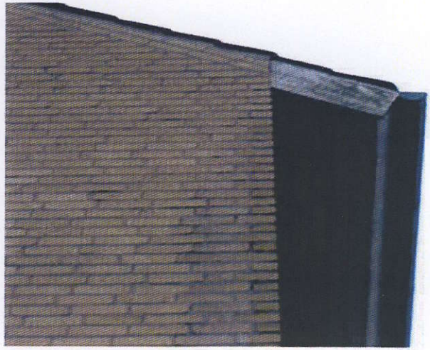
Sætningsrevne på hjørnet ved nr. 31
