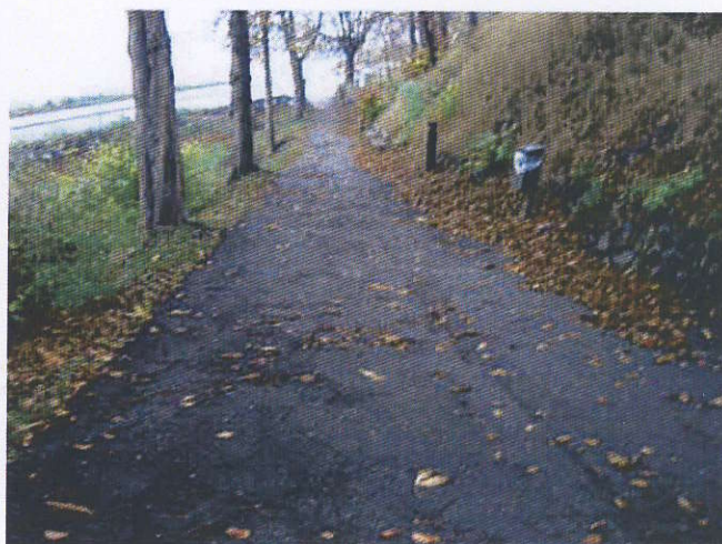
Asfaltbelægning på nedkørsel til Strandvejen fremstår i dårlig stand med mange skader
