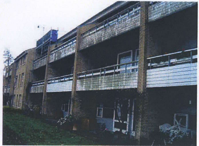
Altaner i lejligheder ifm. opgang 17-31 fremstår misfarvet mange steder. Rækværk af træ
