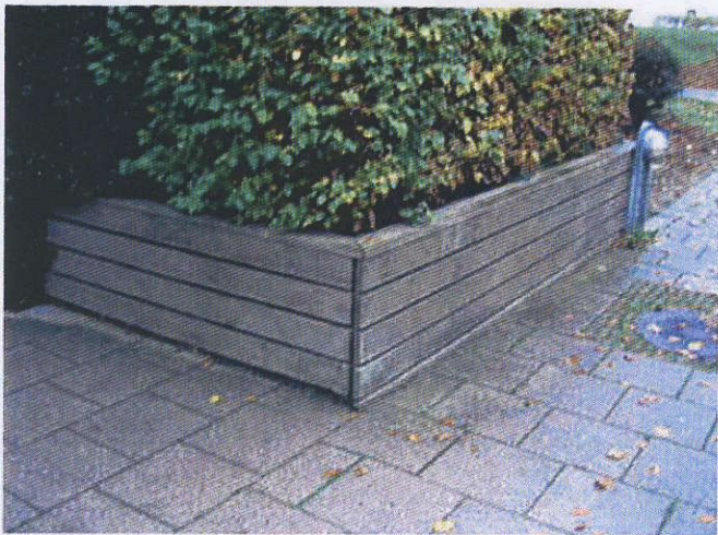
Træværk omkring bede trænger til afrensning og træbeskyttelse mange steder
