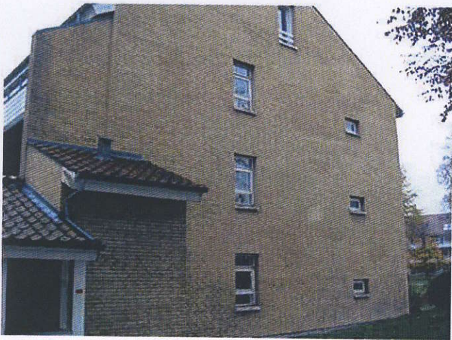
Gavl v. opgang 17
