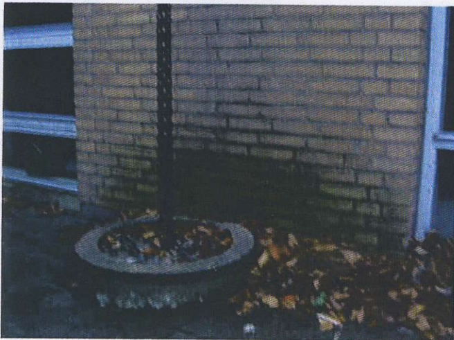
Murværk ved fælleslokaler uden algebekæmpende middel
