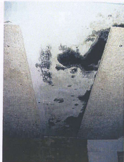
Skimmelsvampeangreb på loft i fællesrum i kælder
