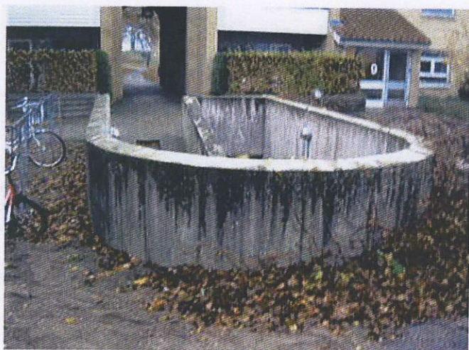
Udvendig kældertrappe af beton, trænger til renovering
