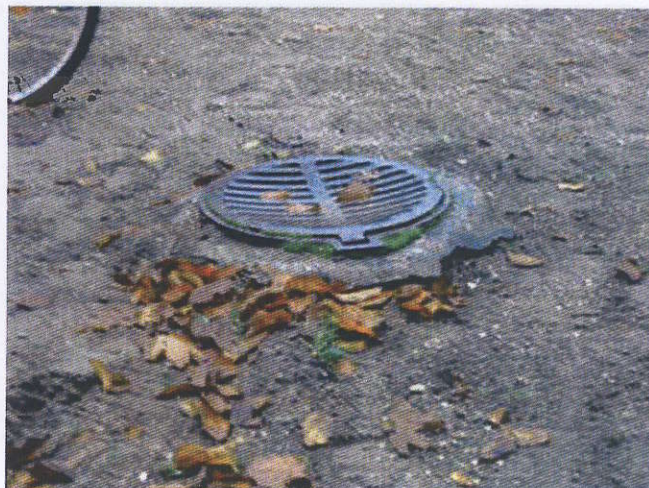
Sætninger i terræn, højtliggende afløb
