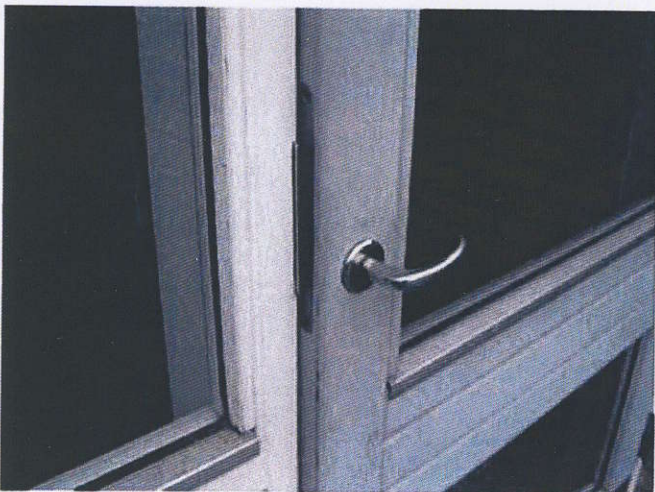
Døre i indgangspartier lukker dårligt og flere dørpumper bør udskiftes
