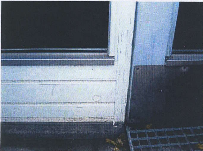
Det vides ikke hvornår døre og vinduer sidst er malet. Overfladen fremstår flere steder med mindre huller og revner
