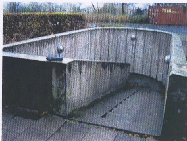
Udvendig kældertrappe af beton, trænger til renovering
