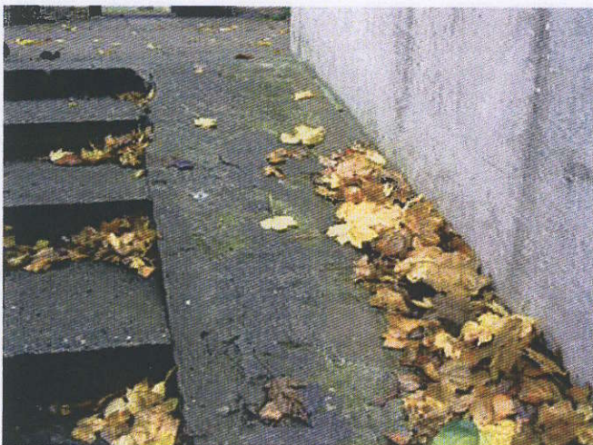
Udvendig kældertrappe, skader på beton mange steder, i alt 4 trapper
