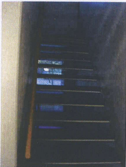
Trappetrin beklædt med kautsjuk (gummibelægning)
