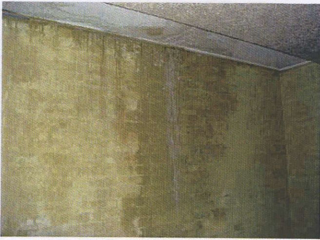
Fugtskade på væg og loft i fællesrum i kælder
