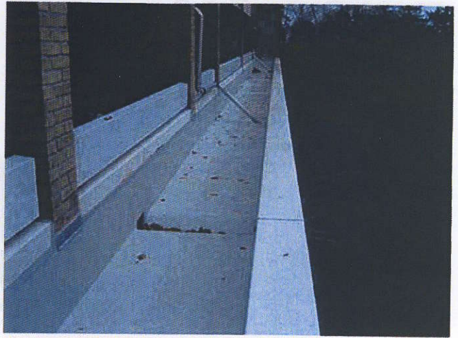
Vandkasse af beton over fællesrum, renoveret for nylig
