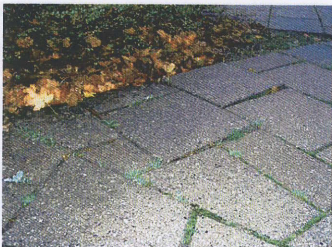
Der er konstateret mindre skader på flisebelægningen omkring bygningerne
